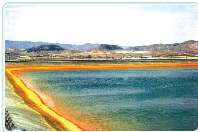
Figura 3.13: Lagoa de estabilização facultativa
