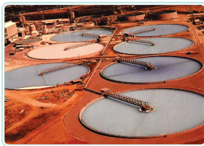
Figura 3.12: Decantadores primários circulares
