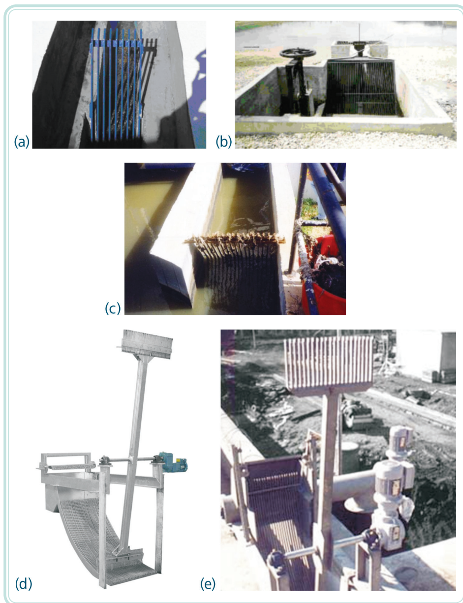
Figura 4.1: Unidades de gradeamento: (a) e (b) aspecto de grades de barras instaladas; (c) desempenho na retenção de sólidos grosseiros; (d) grade mecanizada com rastelo e (e) aspecto do equipamento instalado
