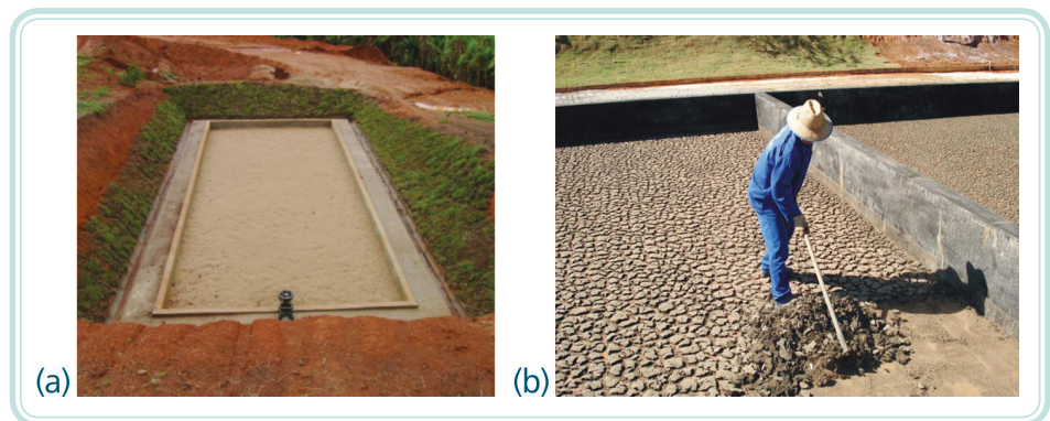
Figura 4.14: (a) Leito de secagem de lodo e (b) remoção do lodo seco
