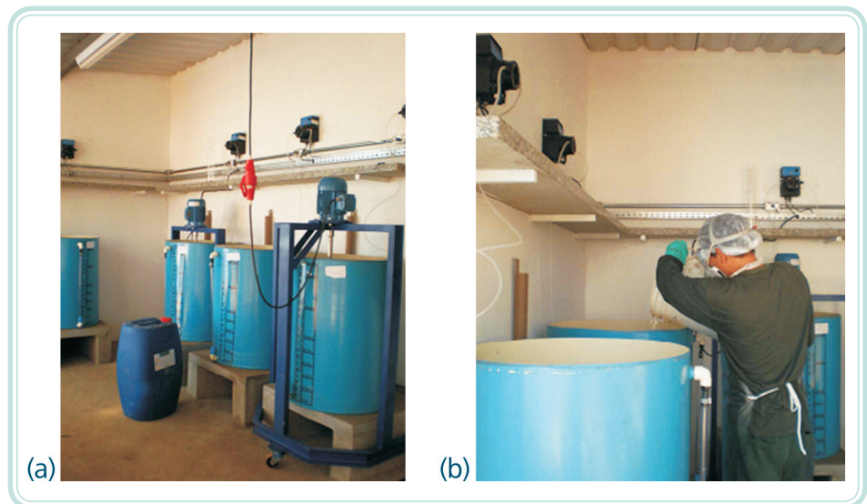
Figura 4.10: (a) Casa de química e (b) exemplos de trabalho neste local Fonte: Fotos dos autores
