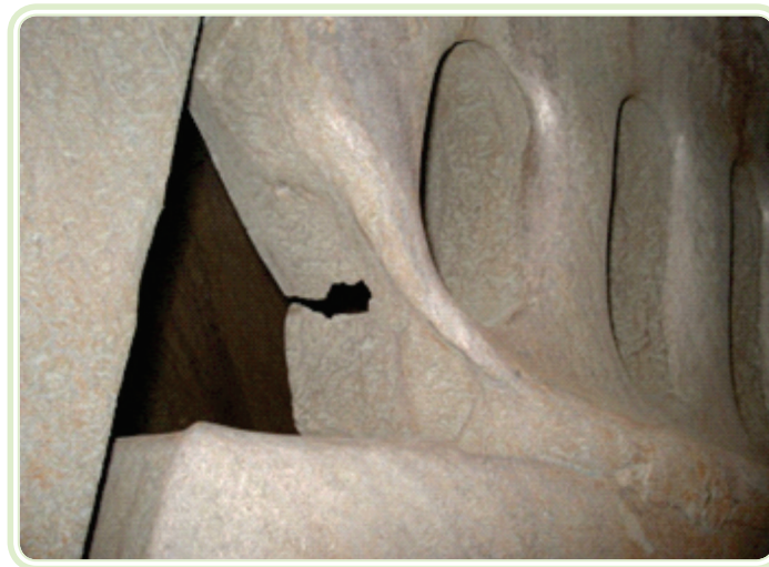
Figura 7.2: Exemplo de falha de material devido a rechupes
