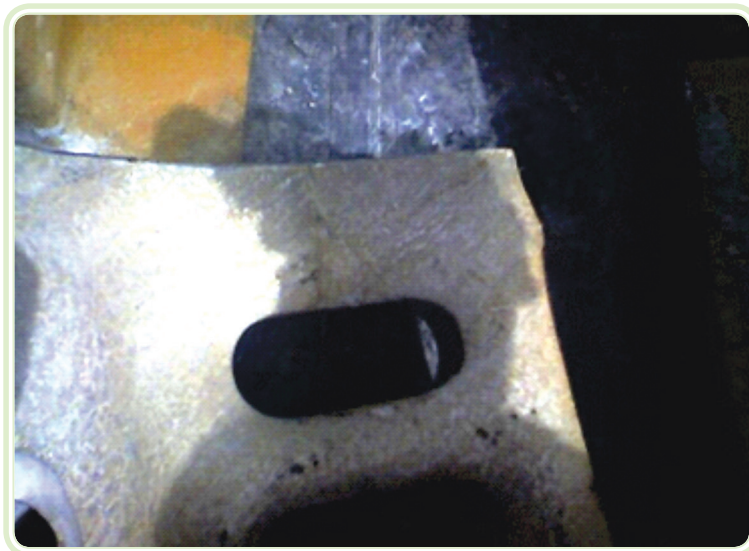
Figura 9.6: Peça em falha por trinca
