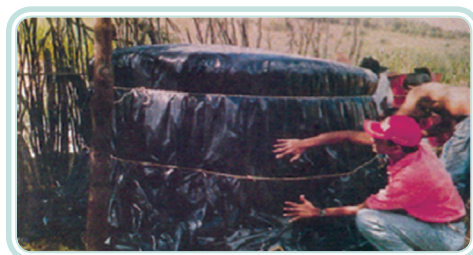
Figura 3.7: Fechamento do silo
