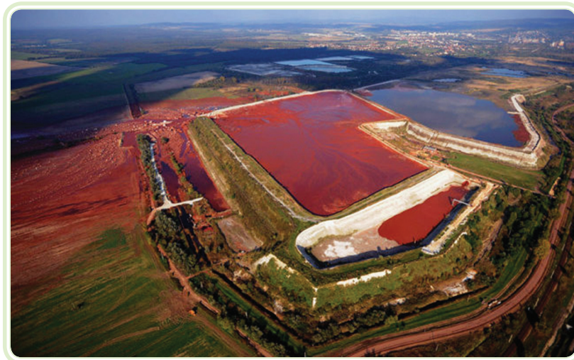
Figura 6.1: Vazamento em tanque de lama vermelha, resíduo da produção de alumínio
