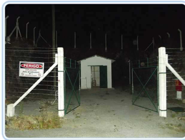
Figura 2.5: Depósito de explosivo
