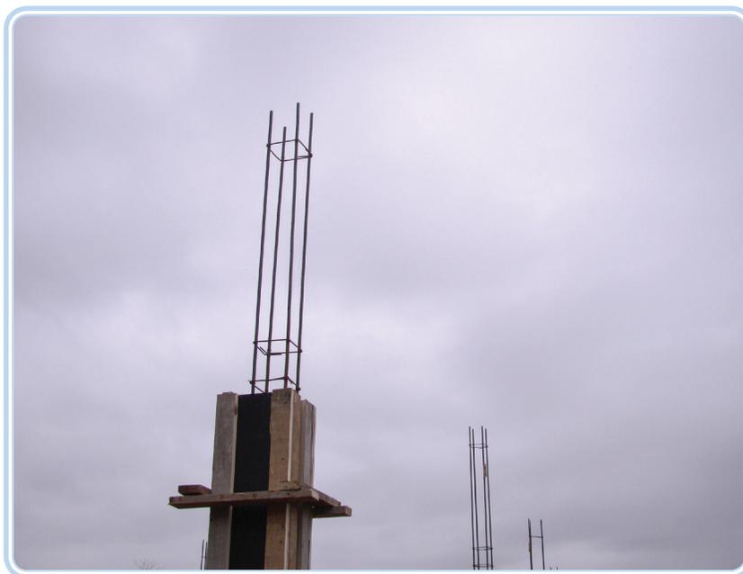
**Figura 4.1: Armações de aço, conforme projeto**
