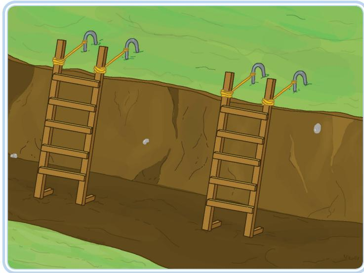
**Figura 3.3: Instalação de escadas em escavação de vala com mais de 1,25 m de altura**
