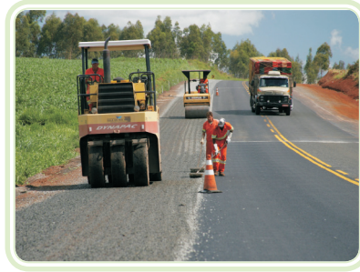
Figura 2.6: Exemplo de construção de estradas
