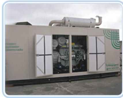
**Figura 1.3: Antecipação – aquisição de grupo gerador com cabine acústica**
