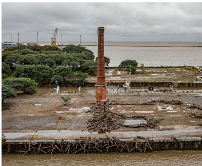
Figura 3: Instalação Desde el otro lado
