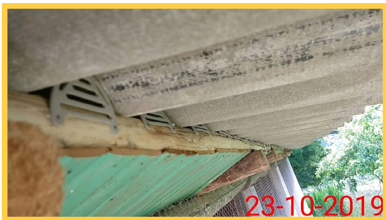
Figura 17: Isolamento de possíveis entradas de pássaros ao interior dos aviários Fonte: Arquivo pessoal de Leandro Magon.
