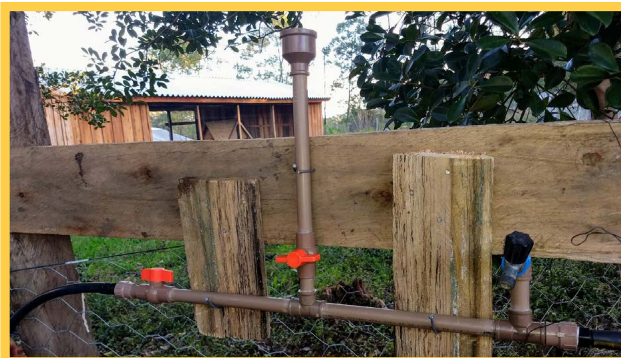
Figura 16: Clorador no acesso da água para o aviário do Sítio Olho D'Água - Jari/RS. Fonte: Arquivo pessoal de Gustavo Pinto da Silva.
