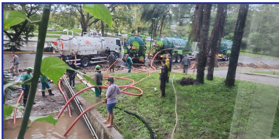
Figura 02: Sucção da água do local do alagamento (Fotógrafo: Tiago Tagliapietra)
