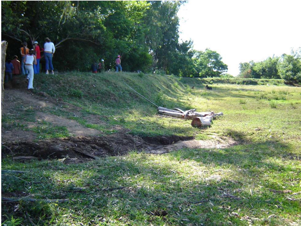
Talude de proteção próximo as margens do Arroio do Meio.
