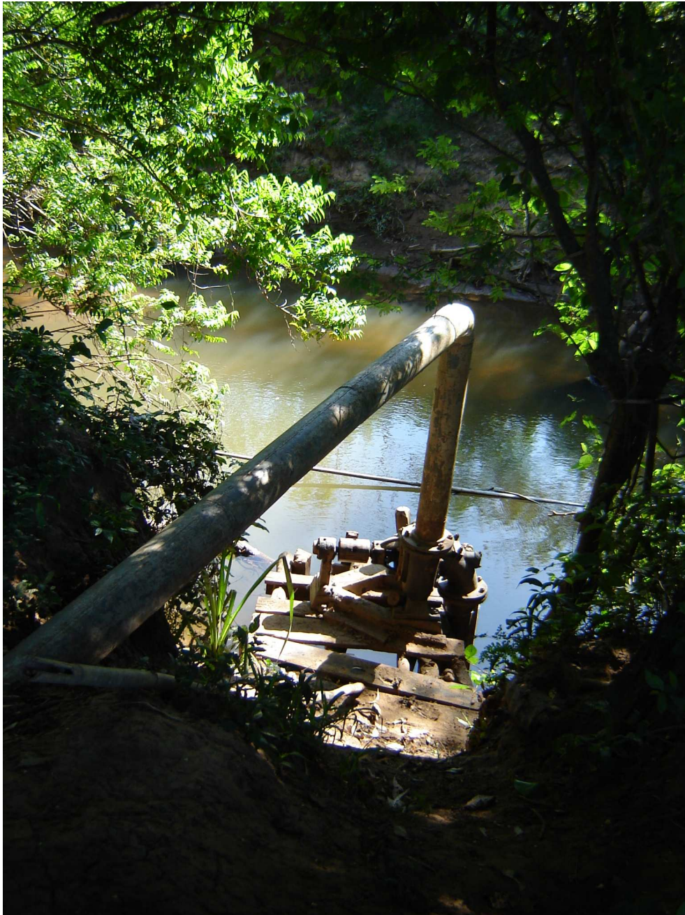
Conjunto moto-bomba na margem do Arroio do Meio para o recalque de água para a lavoura de arroz.
