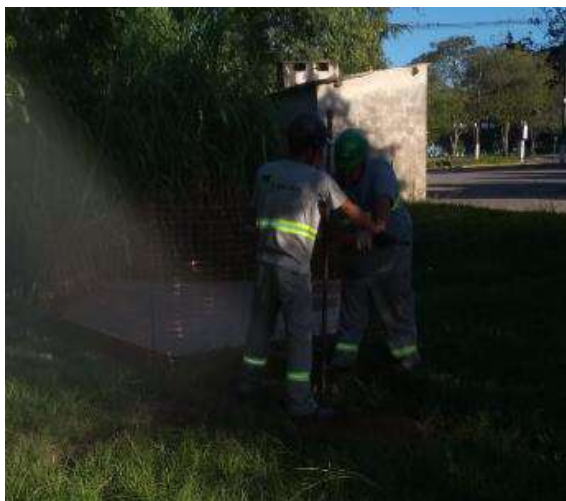
FOTO 09: Execução de sondagens
