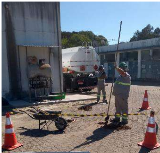
FOTO 10: Execução de sondagens
