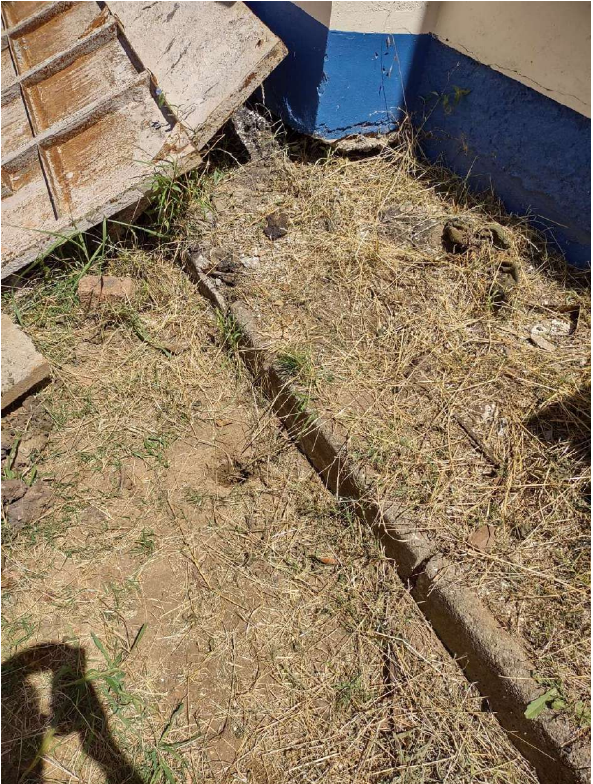
Figura 6 – Depósito de resíduos de combustível, provavelmente óleo B1, diretamente no solo, na área de abastecimento do RU.
