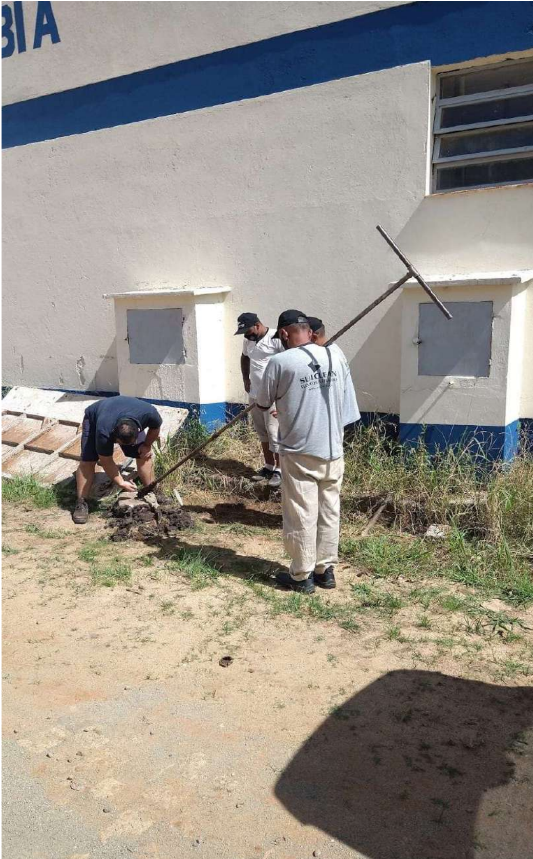
Figura 7 – Coleta de amostra teste, realizada em 23/11/2021, em ponto ao lado do RU, com auxílio da equipe da Sulclean. Pode-se notar a dimensão do tardo manual utilizado, cerca de 3,2 m.
