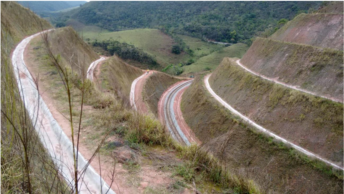
Figura 82: Rodovia em corte com banquetas e valetas de proteção.
