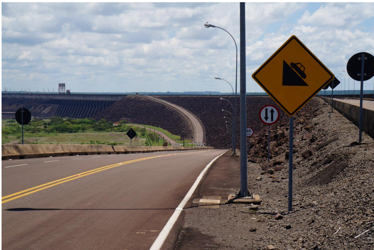
Figura 56: Trecho rodoviário com rampa acentuada.
