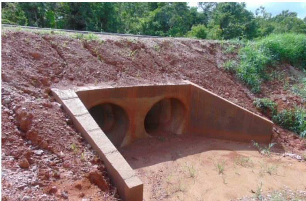
Figura 62: Bueiro com recobrimento necessário.
